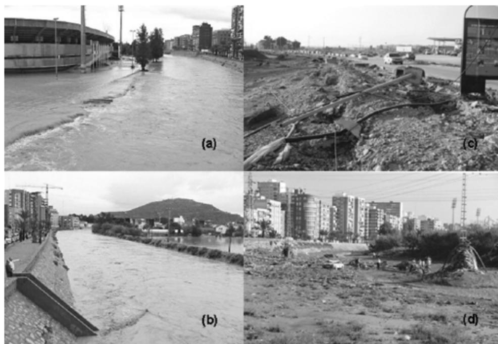
**Figura 8:** Rambla de Benipila, 23 de octubre, 2000. Desbordamiento sobre el margen derecho, que provocó la inundación del estadio municipal de fútbol (a) y su llanura de inundación (b). Efectos de la avenida sobre la carretera que cruza el lecho de la rambla en San Antón (c) y aguas abajo (d).
